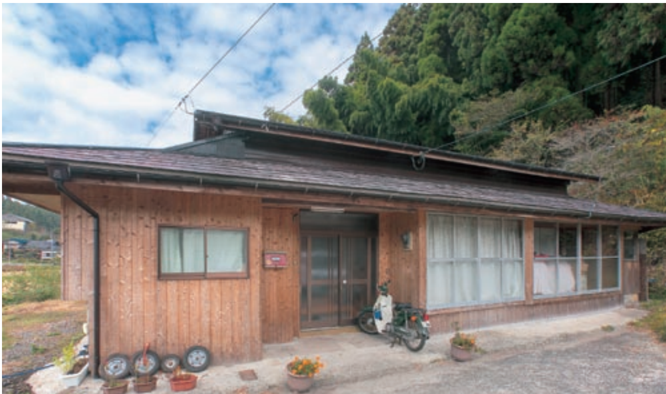
木目調の外観に改修された田尻集落の空き家住宅
